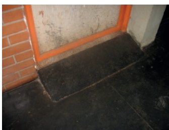
Figura 12: Rampa de acesso à sala de aula
