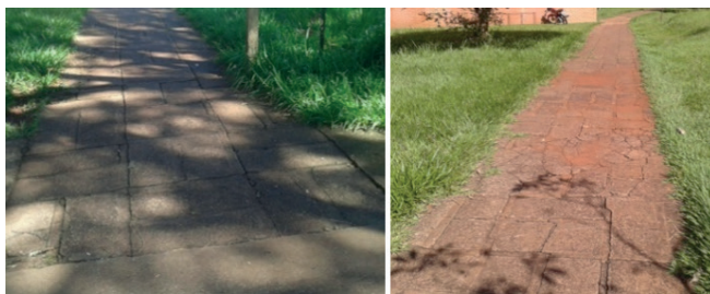
Figuras 6 e 7: Acesso do estacionamento até as salas de aula do CTU
