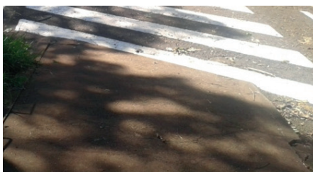
Figura 5: Acesso do estacionamento por meio de rampa
