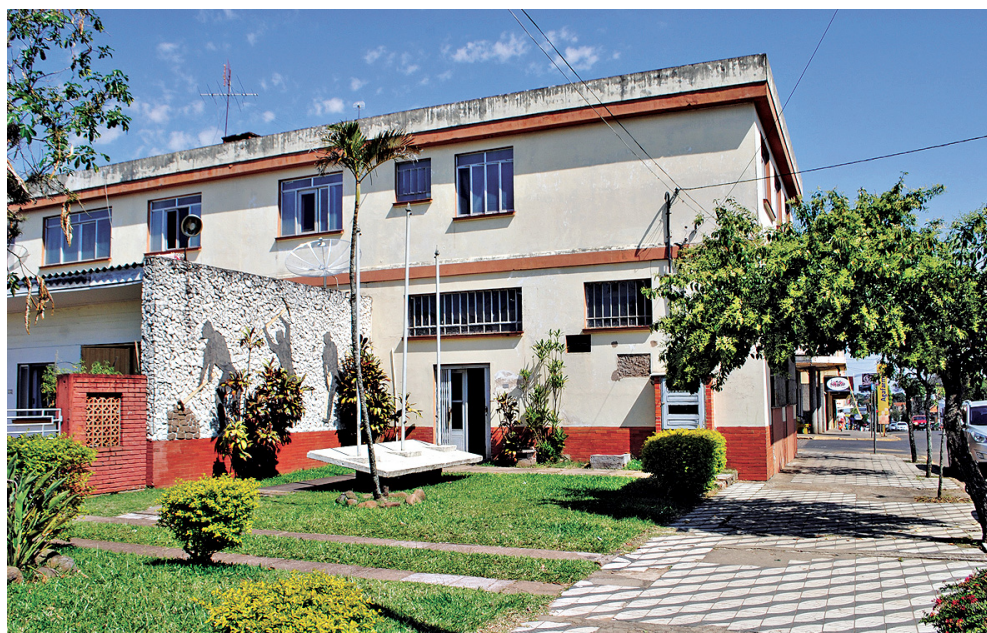
Andar térreo do prédio do Daer, na esquina da Avenida Brasil com a Rua Ivo Becker, precisa passar por reformas para abrigar o IGP
